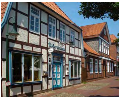
Skelettbauten (Fachwerk) und Massivbauten in Bremervörde mit intakten Fassadenstrukturen und angemessener Farbgebung
