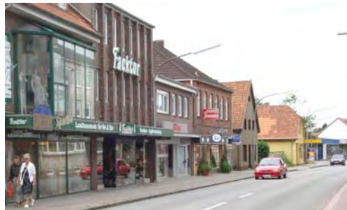
Baufluchtüberschreitungen durch Bauteile und Vordächer und unabgestimmte Höhen- und Baumassenverteilungen in der Alten Straße
