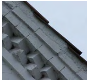
Ziermauerwerk und Mörtelband
