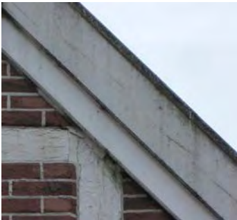
Ortgangbretter mit Windfeder
